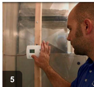
5 Turn on the air handler fan
