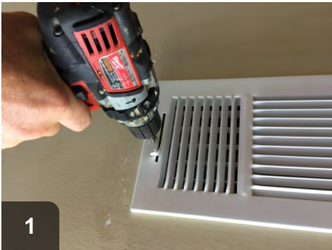
Remove diffuser
